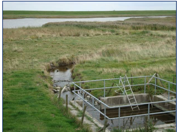
Uitstroom vijzel met opvangbekken
