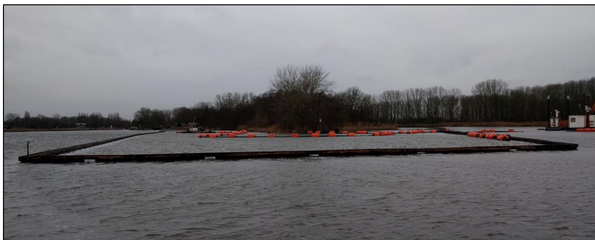
Aanleg van een natuurvriendelijke oever bij Pekland in de Rotte (ZH). Foto Christa Groshart
